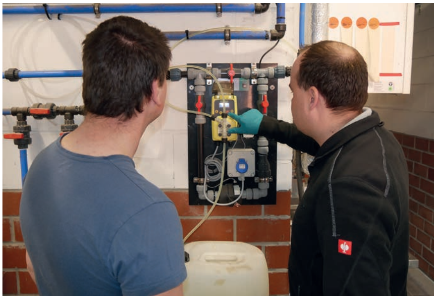
Robert Altena (re.) und Emanuel Deters überprüfen die Einstellungen der Chlordioxidanlage.
