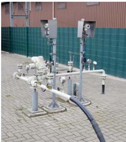
Über diese unscheinbare Rohrleitung wird das gewonnene Biomethan eingespeist.
