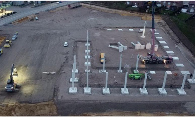
In Reken gehen die Arbeiten für den Raiffeisen-Markt gut voran. Im Dezember wurden die Stahlbetonfertigteile gestellt.
