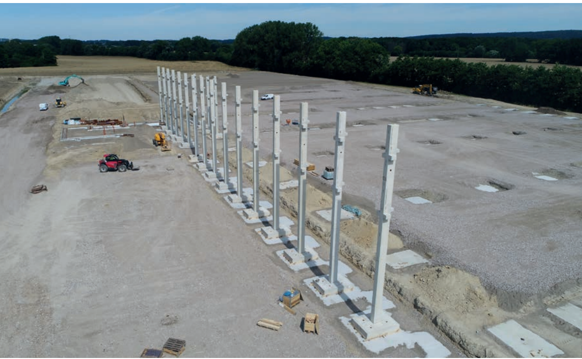
Mehr als 400 Betonstützen werden in diesen Wochen aufgestellt, sodass das künftige Distributionszentrum deutlich sichtbar heranwächst.
