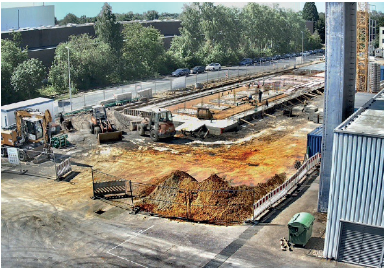
Zwei Baustellenkameras vor Ort dokumentieren die Entstehung des neuen Bürogebäudes. Die Umrisse sind schon klar erkennbar.
